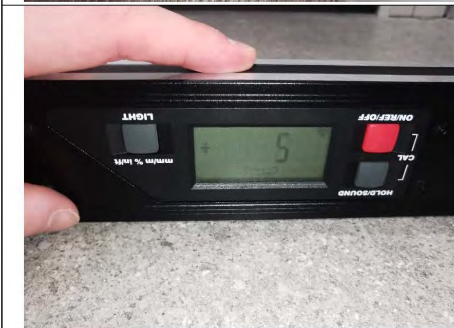
Фото №30. Измерение уровня пола в ванной комнате.
