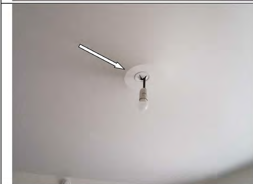
Фото №33. На полотне натяжного потолка в спальне видны инженерные сети.
