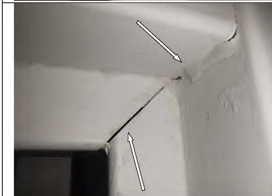
Фото №53. Элементы дверного блока (коробка) соединены не надежно в спальне.
