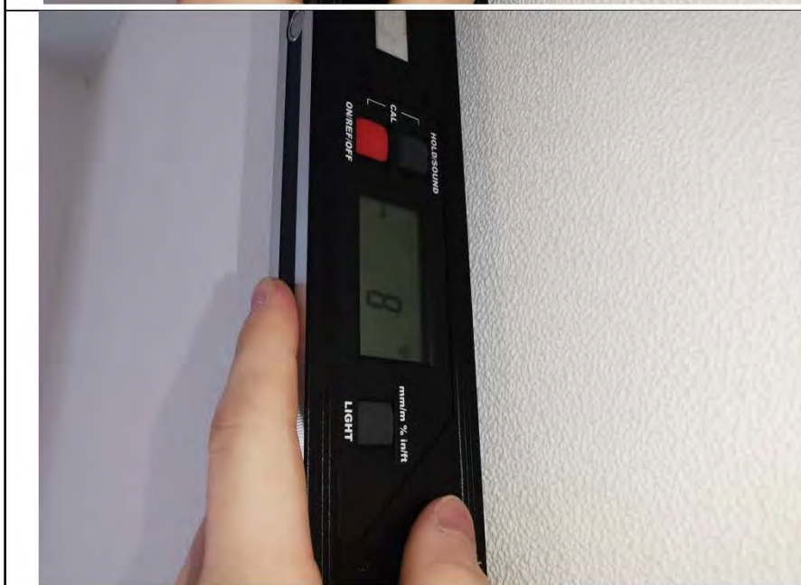
Фото №9. Измерение уровня стен в спальне.
