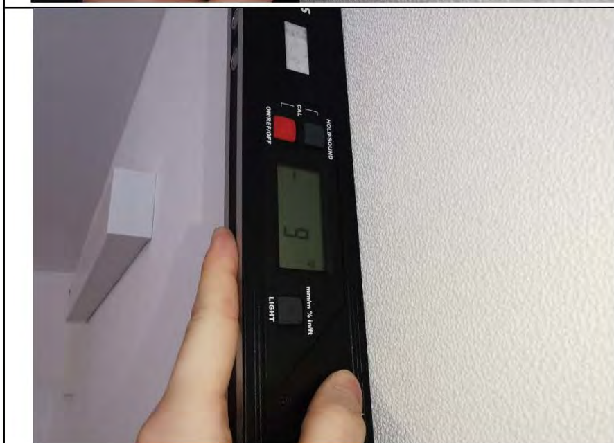
Фото №8. Измерение уровня стен в кухне.
