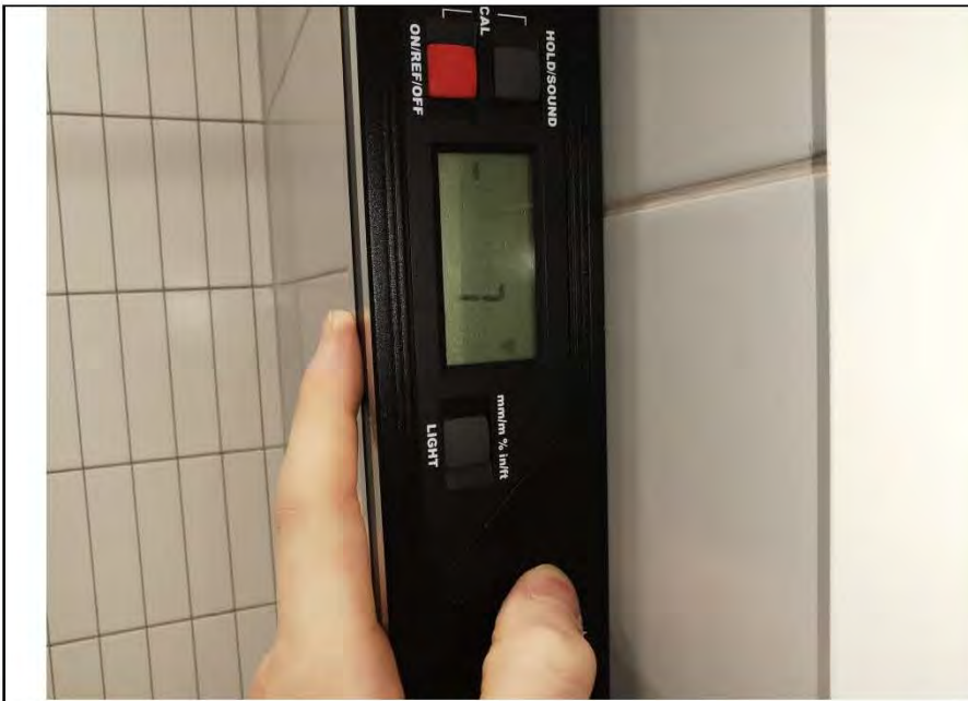
Фото №16. Измерение уровня стен в ванной комнате.
