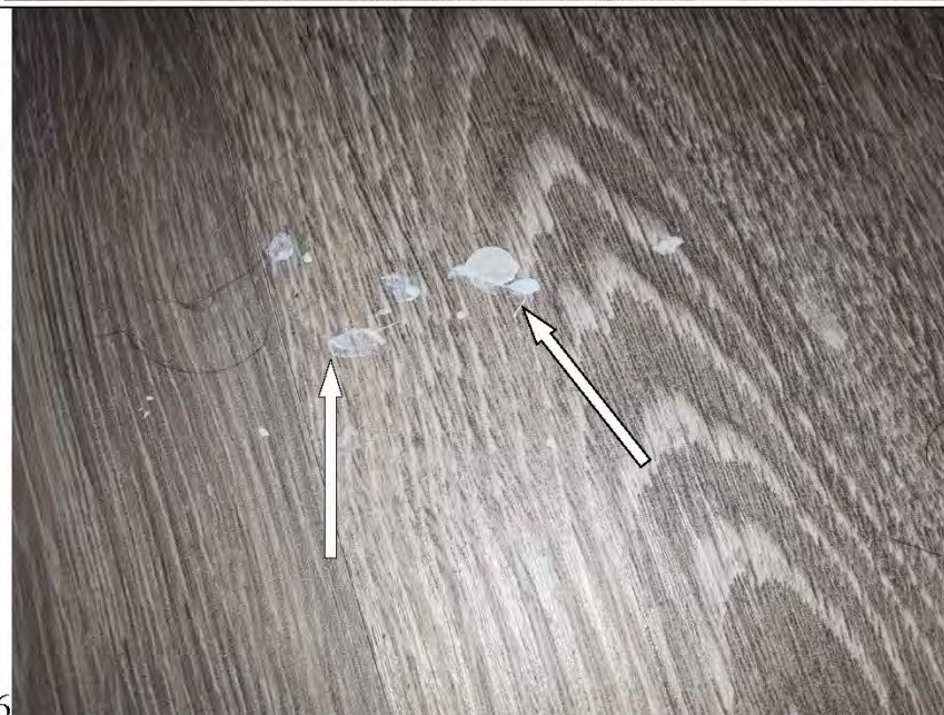
Фото №26. Загрязнение ламината в спальне.
