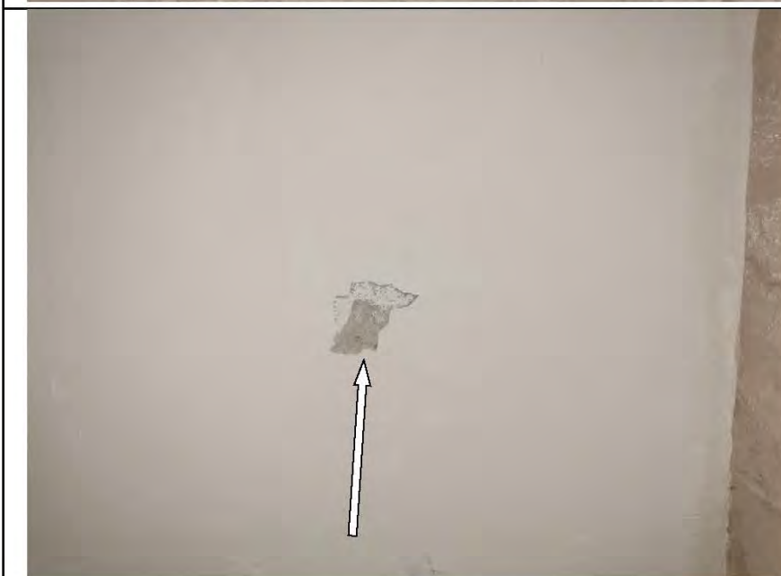
Фото №44. Следы залития на потолке в коридоре (отслоения, разрушение штукатурного слоя, поражение грибком).
