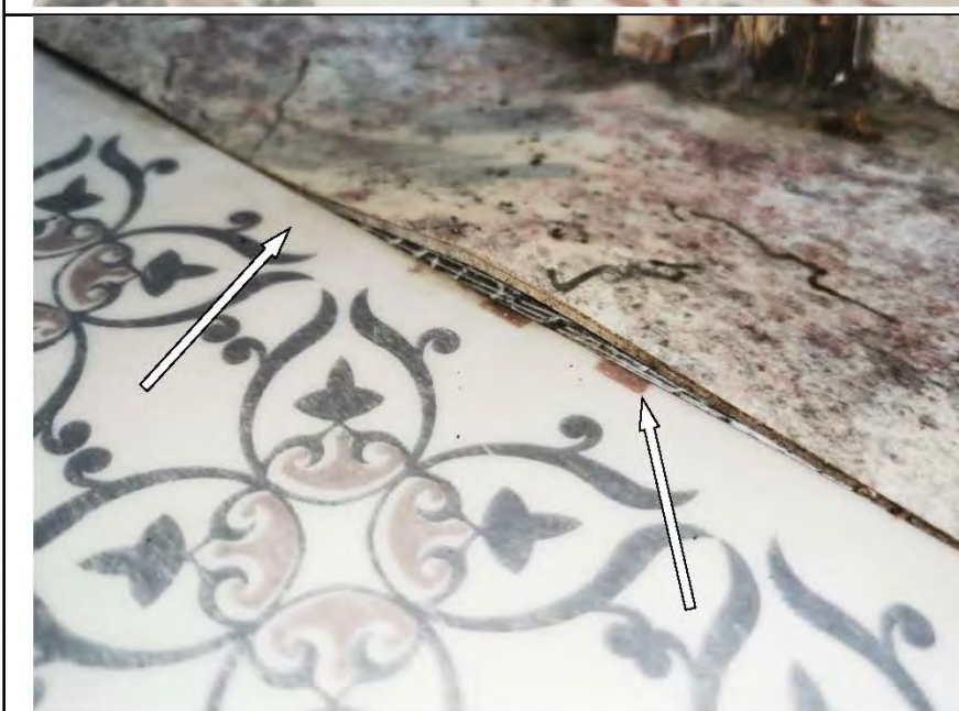
Фото №35. Следы залития на линолеуме в кухне (вздутия, отслоения).
