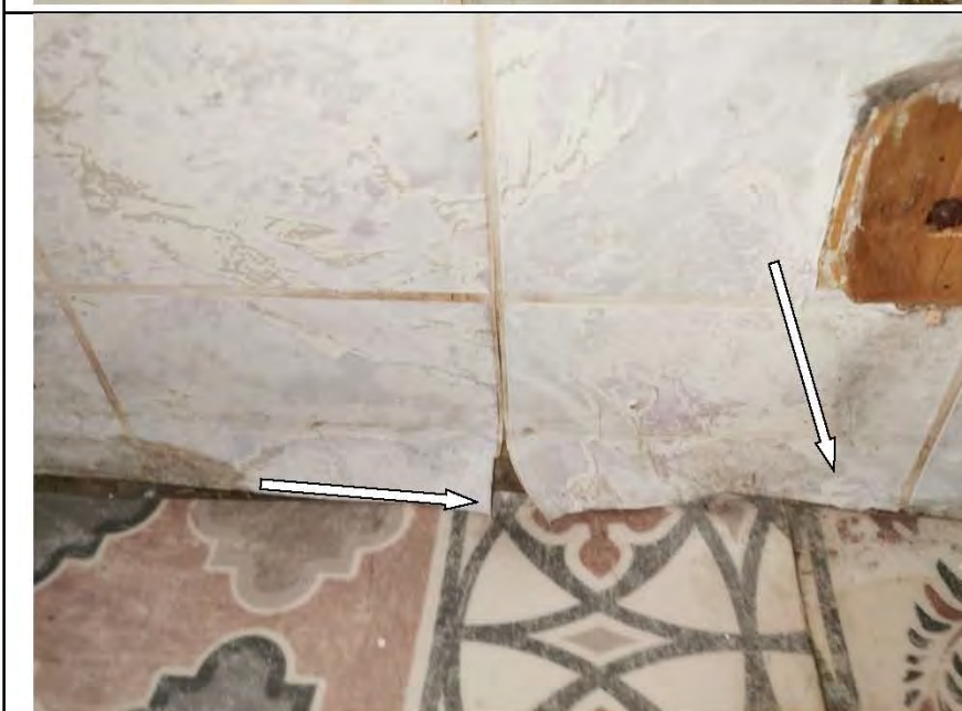
Фото №17. Следы заливания обойного полотна в кухне (вздутия, отслоения).
