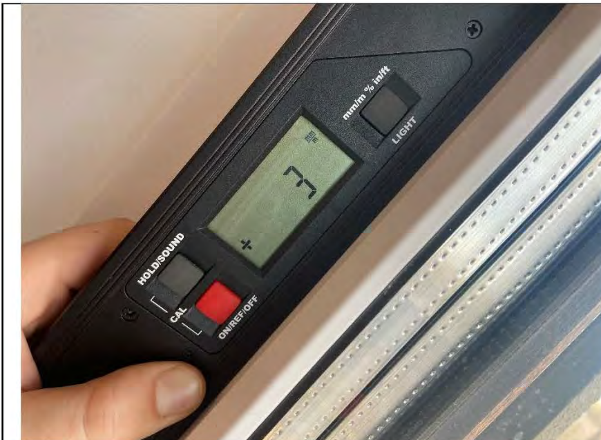
Фото №46. Отклонения по вертикали оконного блока ПВХ в кухне.
