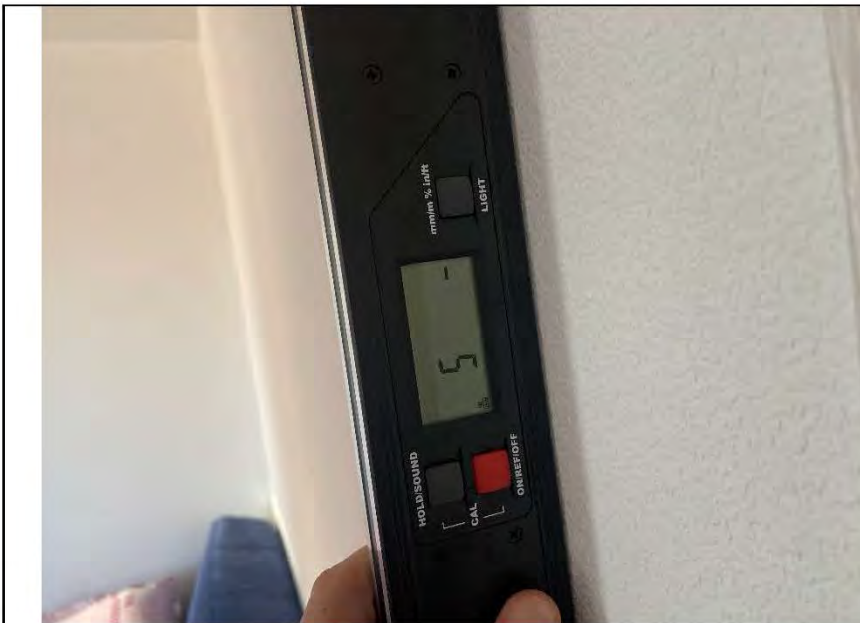
Фото №10. Измерение уровня стен в кабинете.
