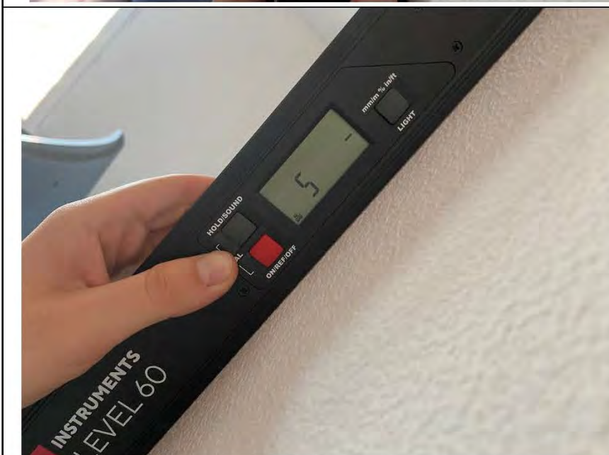
Фото №11. Измерение уровня стен в спальне.
