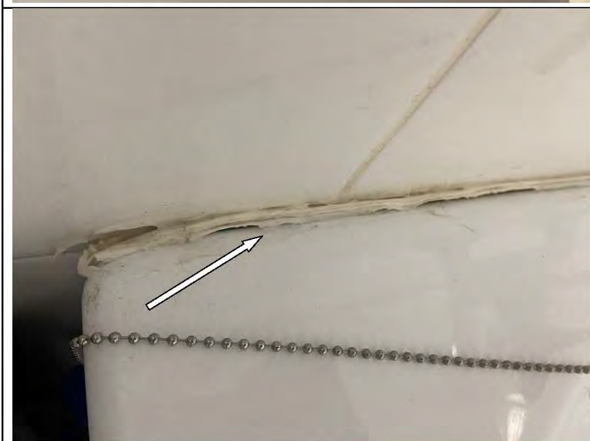
Фото №78. Загрязнения на раковине в ванной комнате.
