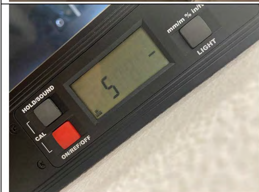
Фото №8. Измерение уровня стен в кухне.
