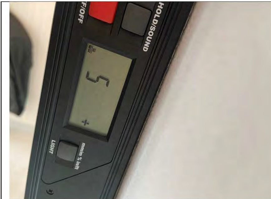
Фото №4. Измерение уровня стен в коридоре.
