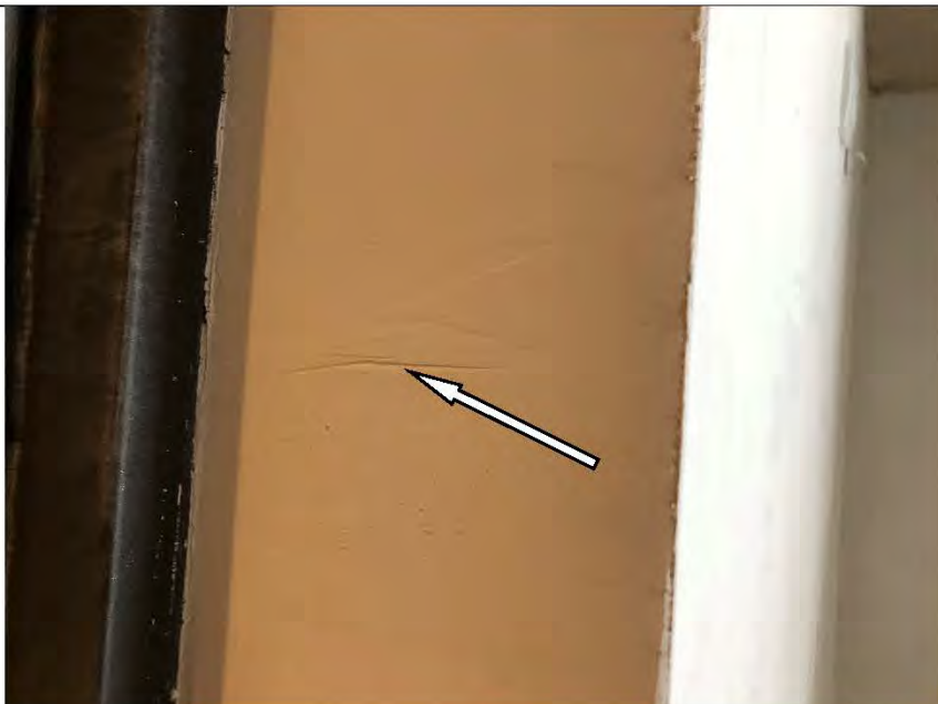
Фото №13. Царапины и следы от инструмента на шпаклеванных откосах входного дверного блока.
