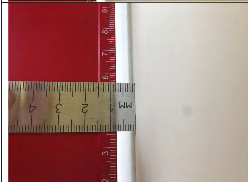
Фото №9. Измерение уровня стен на балконе.
